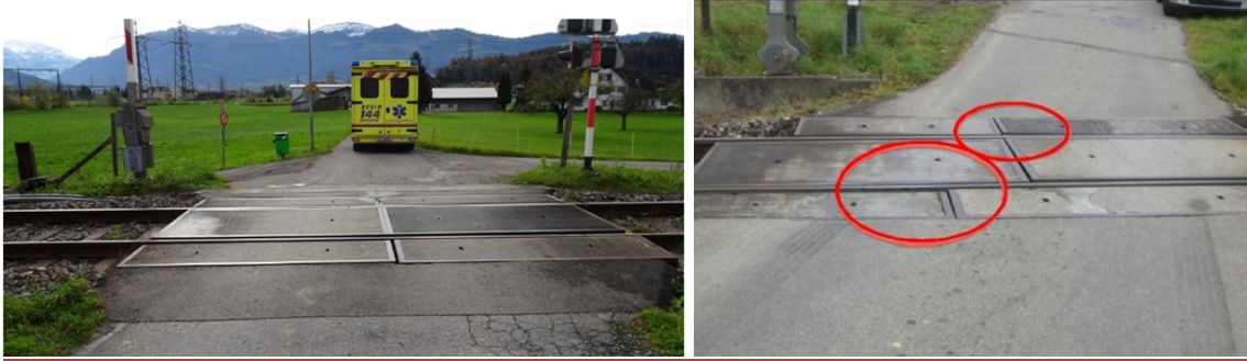
Abbildung 11-2: Spalten im Bereich von BUe, minimaler Winkel
